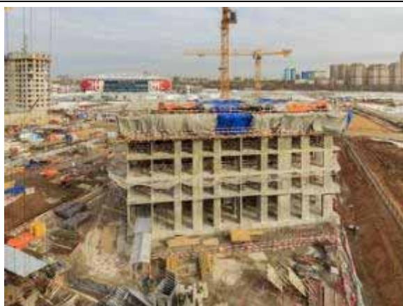
Внешний вид МЖД Корпус 4
