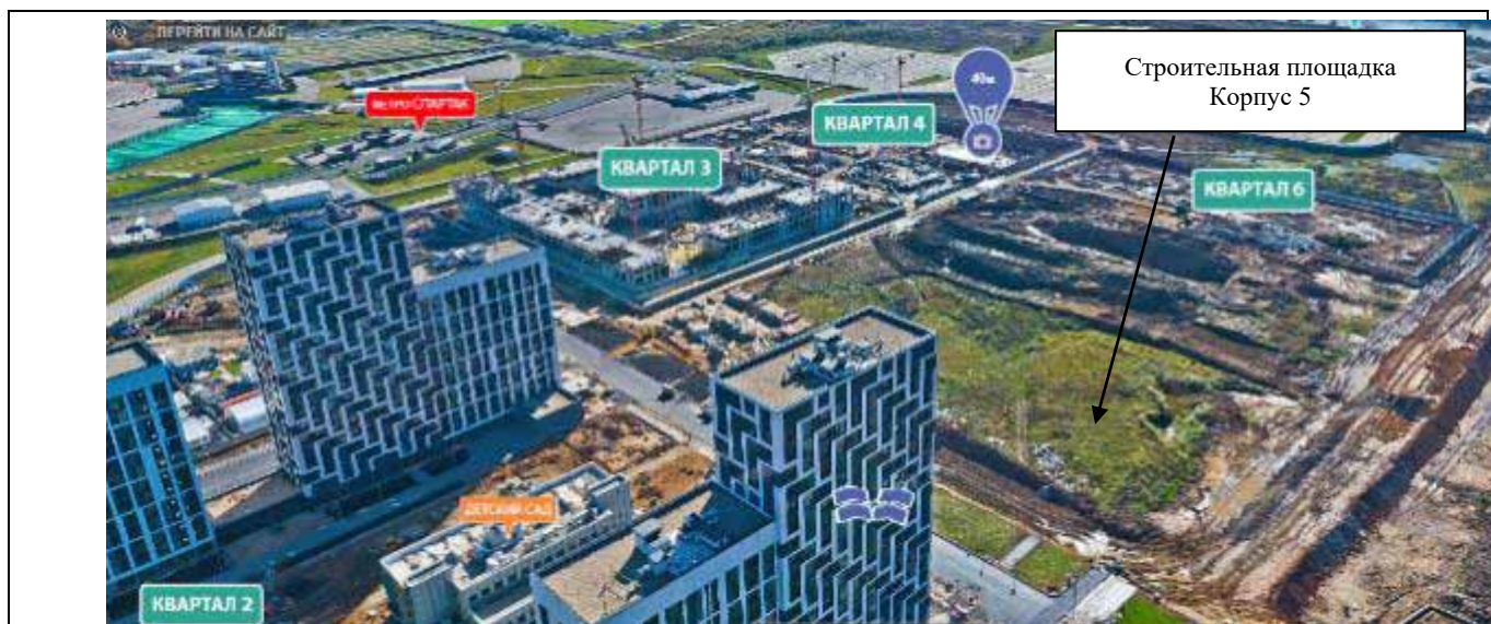
Внешний вид МЖД Корпус 3, Корпус 4, строительная площадка Корпус 5, 6
