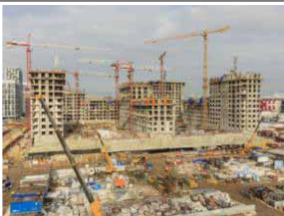
Внешний вид МЖД Корпус 3
