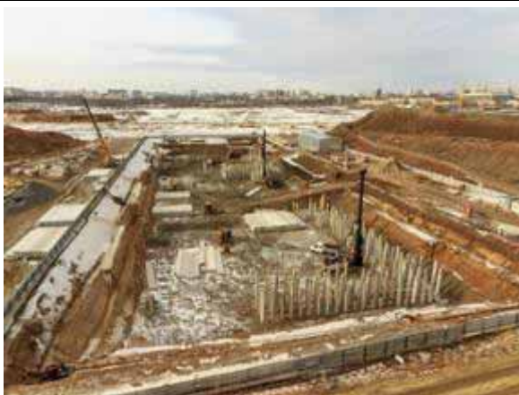
Внешний вид МЖД Корпус 6
