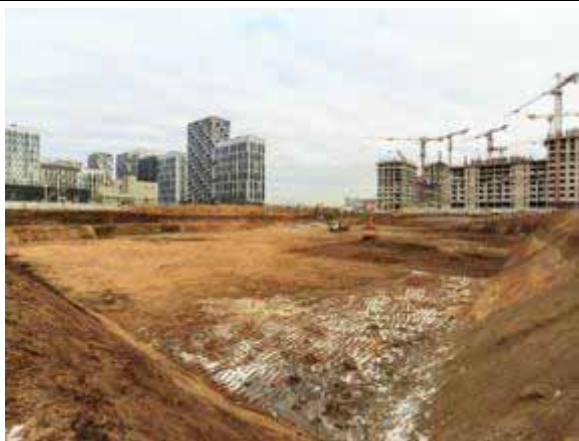
Внешний вид МЖД Корпус 5
